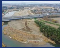
河道掘削状況
