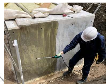
型枠取り外し面施工状況
