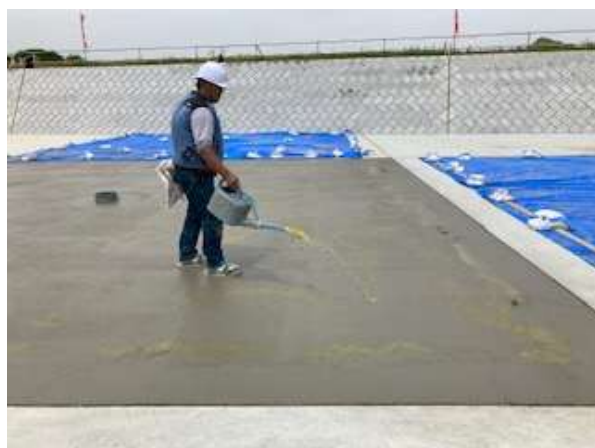
金コテ仕上げ前に SoyShot-20 150ml/m 2 散布
