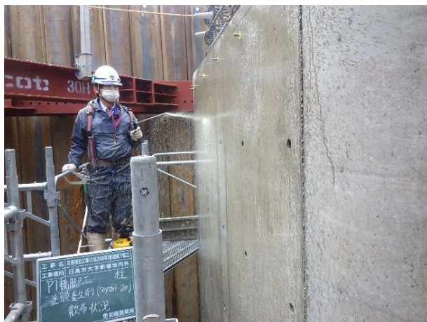
型枠取り外し直後 SoyShot-20 150ml/m 2 噴霧
