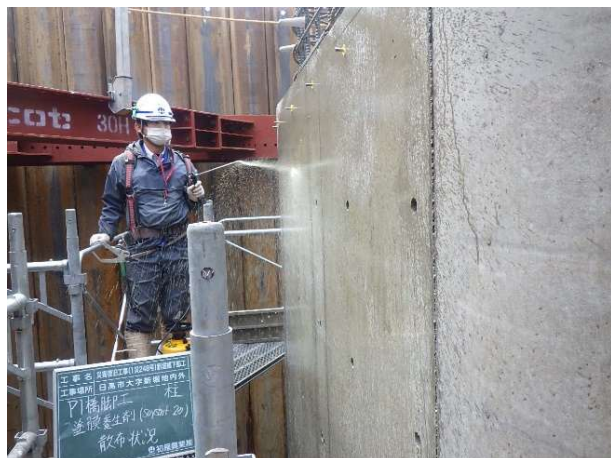
型枠取り外し直後 SoyShot-20 150ml/m 2 噴霧
