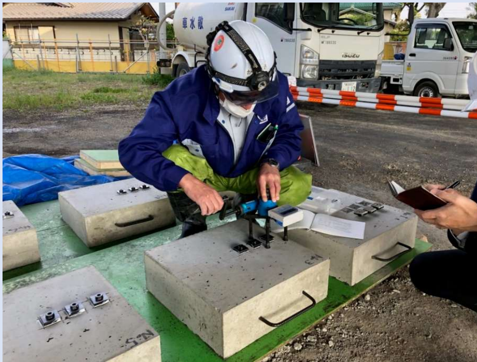
建研式引張強度試験（川越北環状線試験施工）
