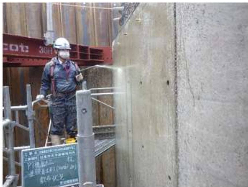
型枠取り外し直後 SoyShot-20 150ml/m 2 噴霧
