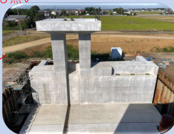
コンクリート構造物の建設
