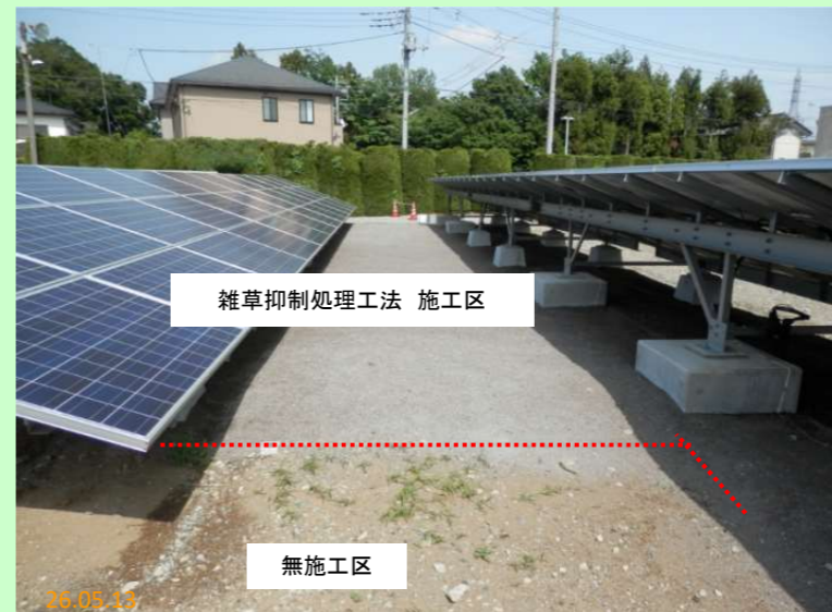
埼玉県坂戸市石井地内 施工日:2013年2月 撮影:施工後 約15ヶ月
