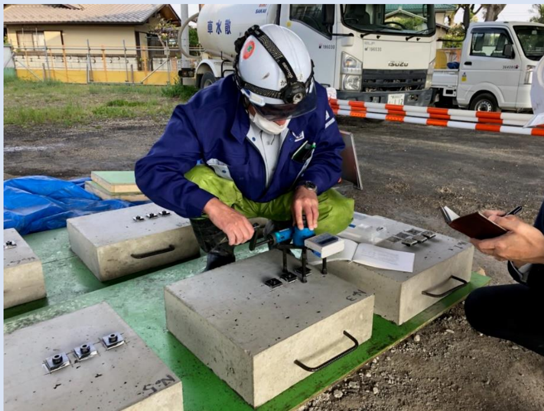
建研式引張強度試験（川越北環状線試験施工）
