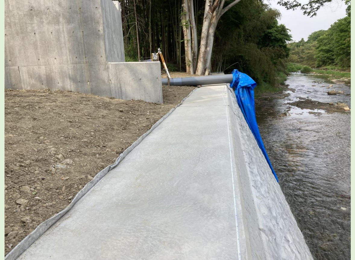
天端コンクリートには左官仕上げ後にSoyShot-20塗布
