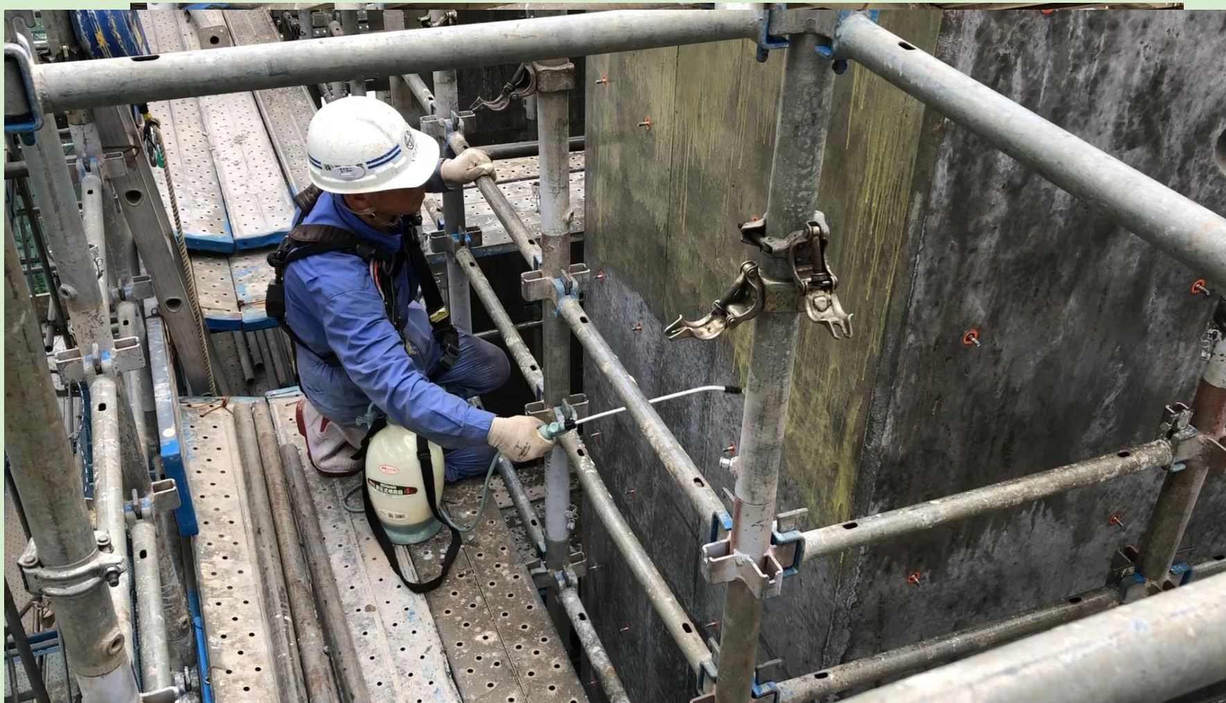
堰柱コンクリート型枠取外し後SoyShot-20塗布状況
