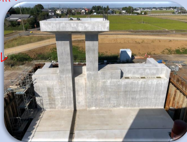
コンクリート構造物の建設
