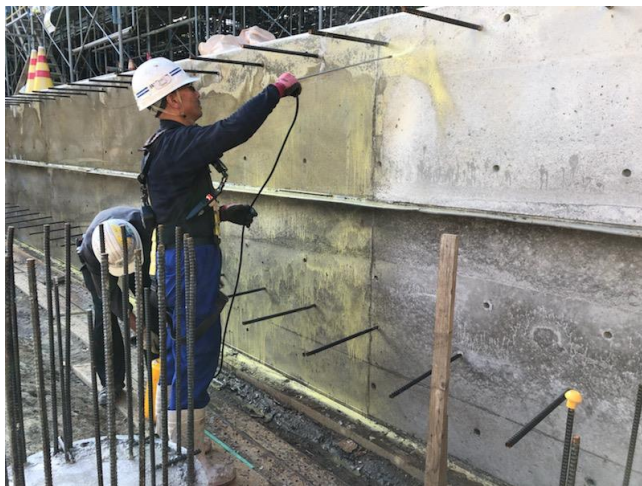
底盤コンクリートへ 150ml/m 2 塗布
