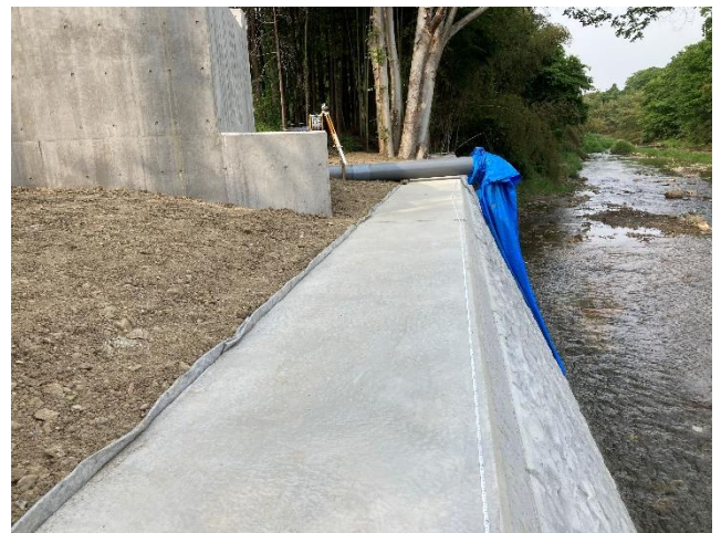
護岸天端コンクリート 仕上げ後に 100ml/m 2 を噴霧
