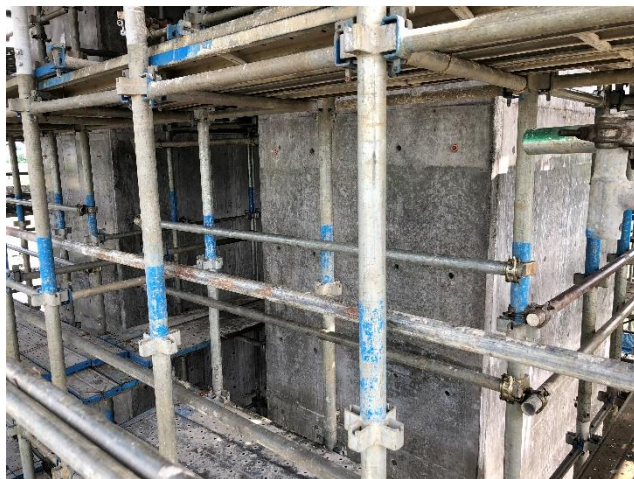
堰柱コンクリート SoyShot-20 塗布 4 日後
