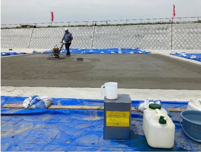
SoyShot-20 100ml/m 2 散布機械金ゴテ仕上げ (土間は 100ml/m 2 )
