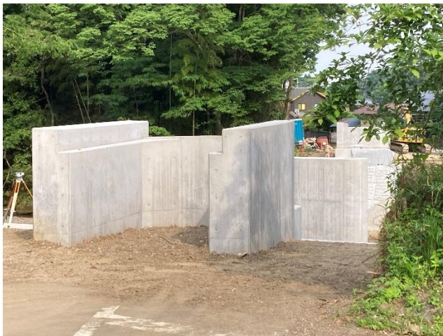
完成時 (A1 橋台 P1 橋脚 A2 橋台) コンクリート打設 4 か月後
